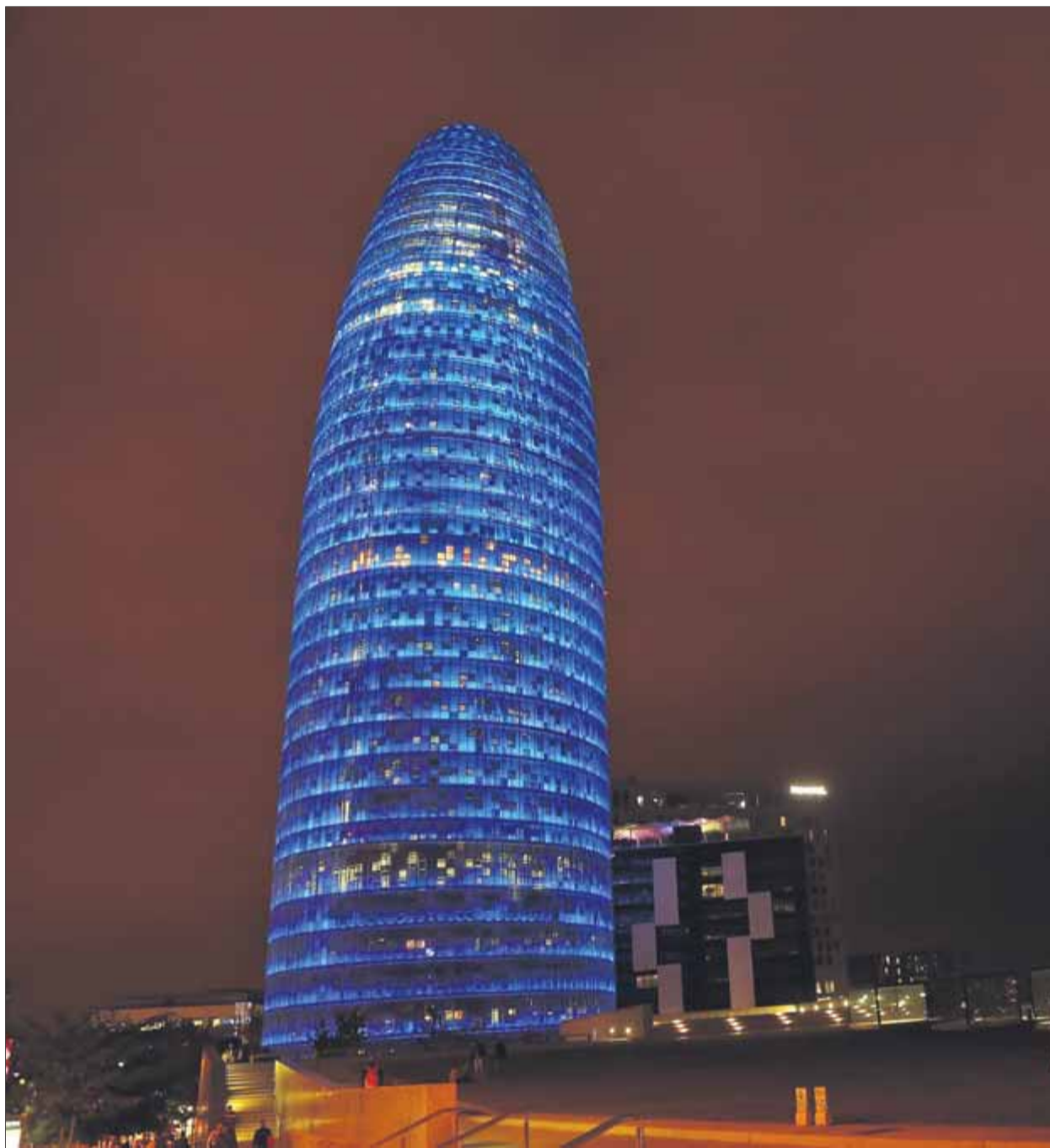
La Torre Glòries és el tercer edifici més alt de la ciutat, amb 142 metres i 34 plantes
