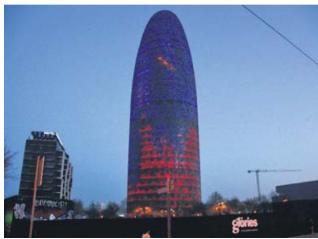
La Torre Glòries debía albergar la sede de la EMA. ACN
