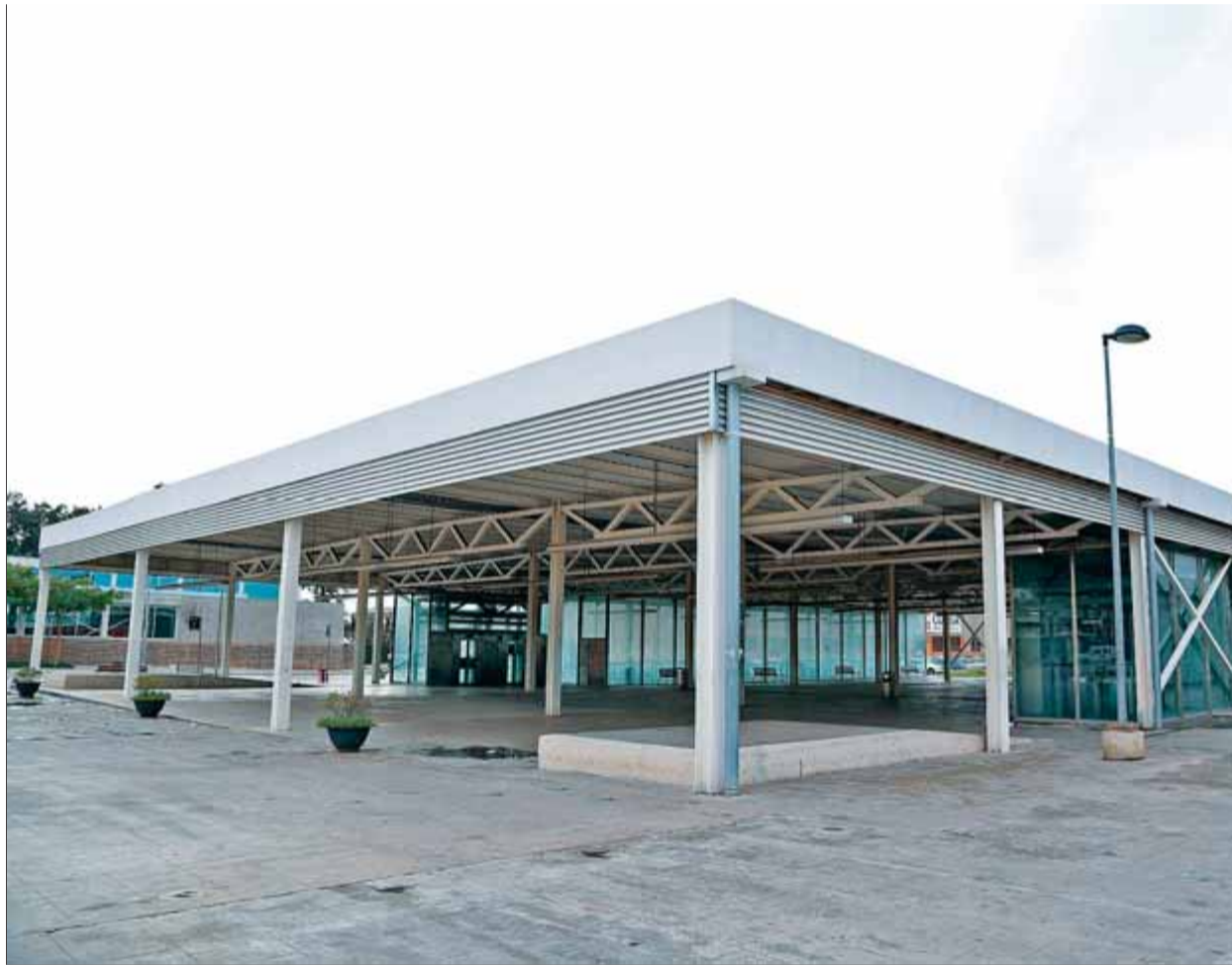
Pèrgola superficial de la que havia de ser l'estació provisional del TAV al Prat i que ha quedat sense ús ■ JUANMA RAMOS
