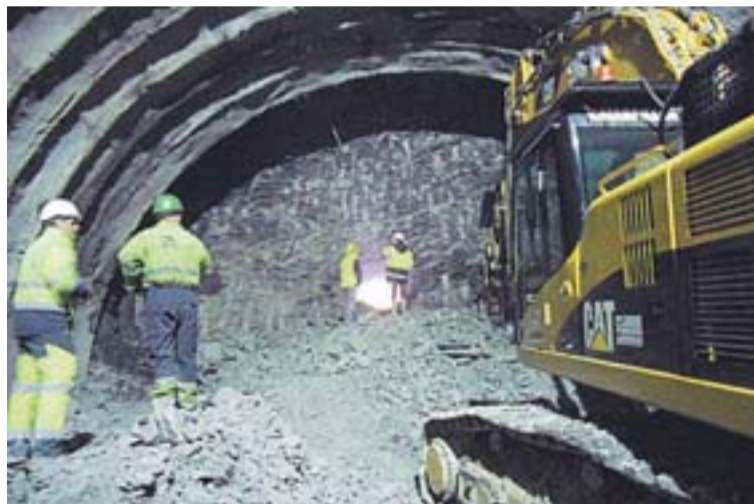
'Cale' del túnel desde el interior de la galería hacia fuera.
