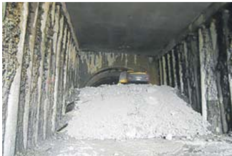
Trabajos de perforación del túnel de Hernani.
